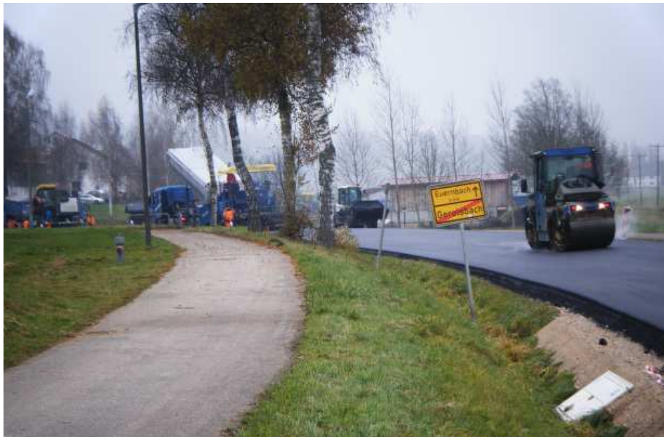
Bild: Asphaltinbau im vergangenen Jahr am östlichen Ortsausgang Gerolsbach
